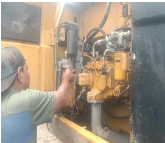
Perbaikan Pada Excavator CAT
